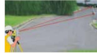
隐蔽点测量主要用于测量那些无法直立棱镜进行测量的点，测量前要先配置杆的长度和棱镜间距，隐蔽点测量杆可以任意角度放置在隐蔽点上，测量完成后程序可以计算出隐蔽点坐标。
